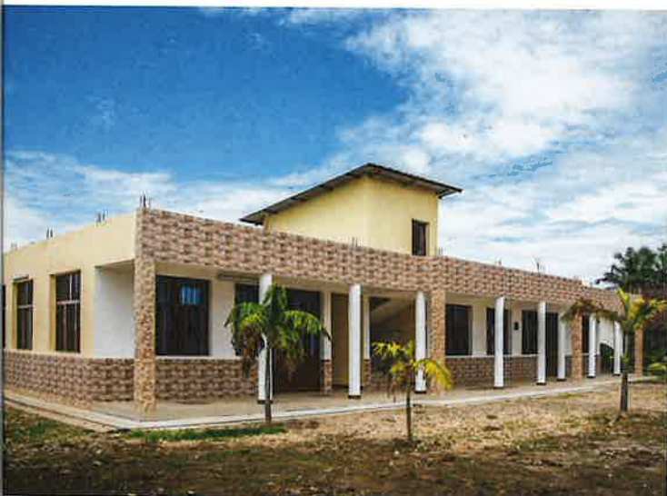
Der neue Anbau der Bildungsakademie in Burundi.
